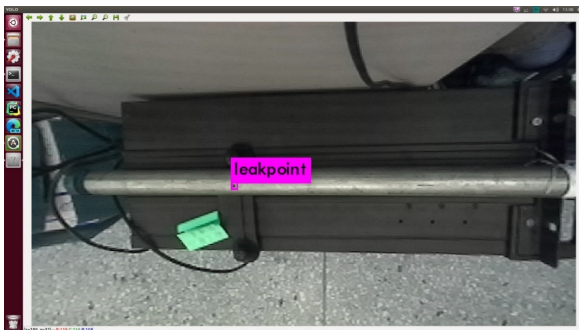
图 4-12 室内环境下的管道漏点检测
