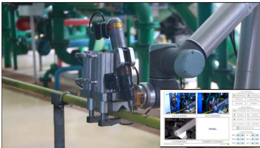
图 6-25 捻打气锤工作以修复管道
