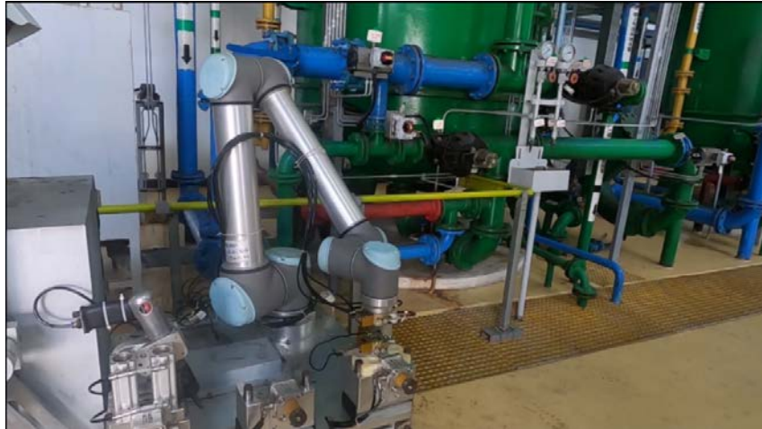
图 6-17 机械臂卸载定位末端
