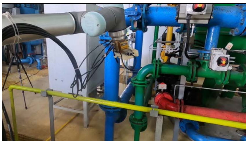
图 6-15 管道泄漏检测并准备进行管道漏点定位
