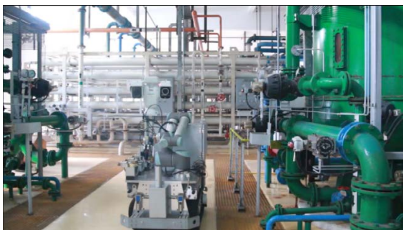
图 6-27 修复完成后机器人离开
