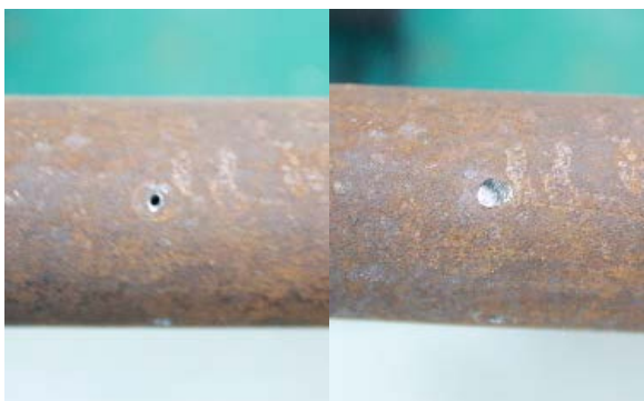
(b) 管道漏点与 70^\circ 管道修复效果
