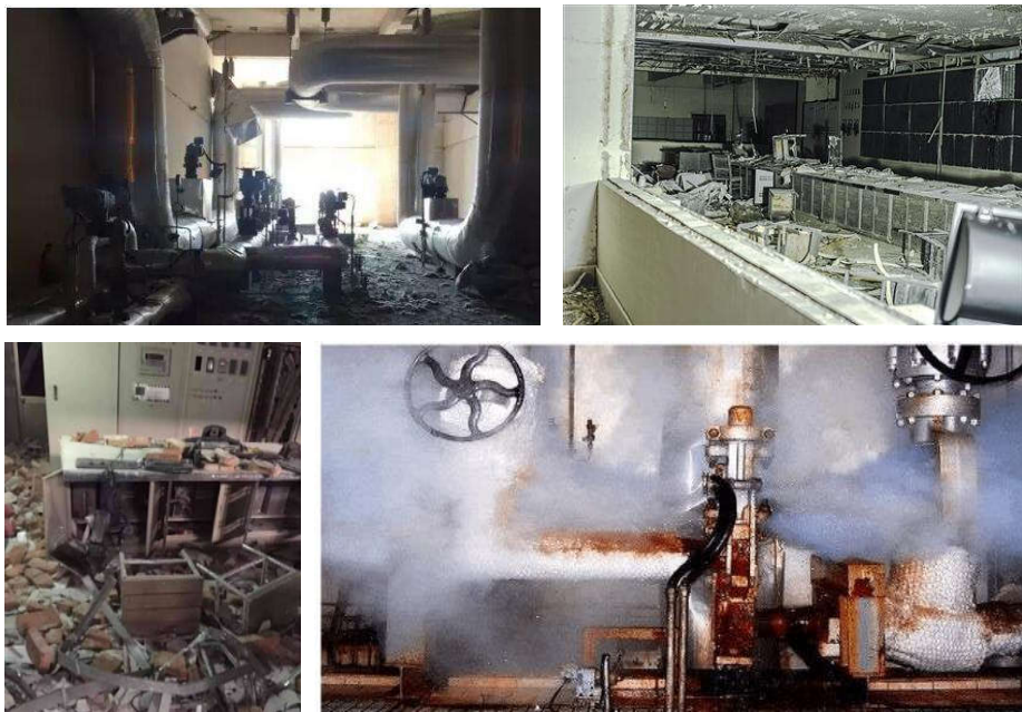
图1-1 电厂锅炉泄漏爆炸事故现场照片
