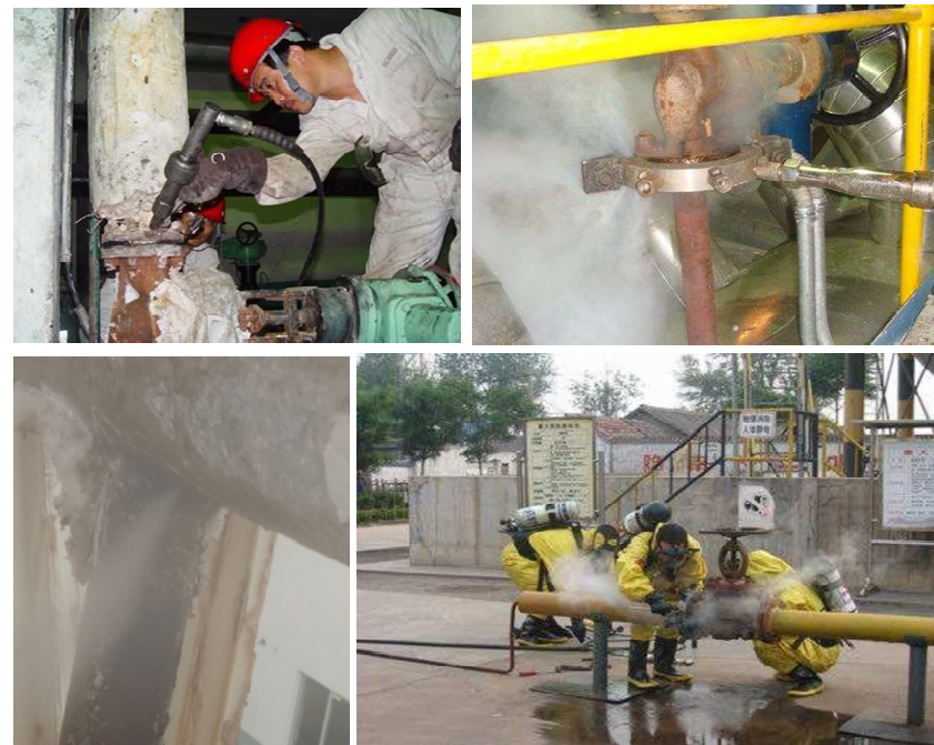
图1-2 传统带压堵漏作业现场照片
