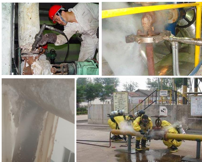
图 1-3 传统带压堵漏作业现场照片
