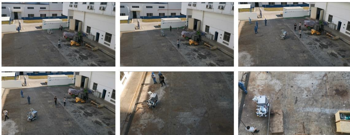
图 6-9 带压堵漏机器人从库房进入模拟泄漏现场
