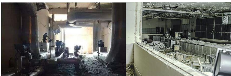
图 1-1 湖北当阳电厂爆炸事故现场照片
