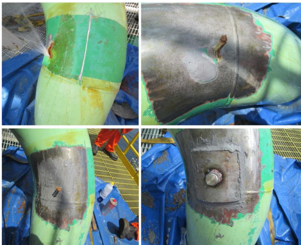
图 1-5 使用高性能高分子复合材料进行海水管道泄漏修复的过程
